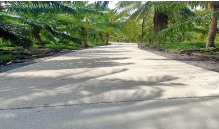
โครงการก่อสร้างถนน คสล.สายเสม็ดเอน ๑ (ตอน ๓) ม.๒
