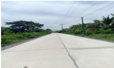
โครงการก่อสร้างถนน คสล.สายแหลมป้-บางม็ก ม.๑,๒
